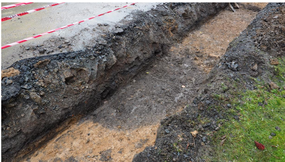
Obr. 9. Hradec u Stoda, III. etapa stavby kanalizace. Ve dně výkopu začištěný půdorys objektu 49, pohled od JV.
