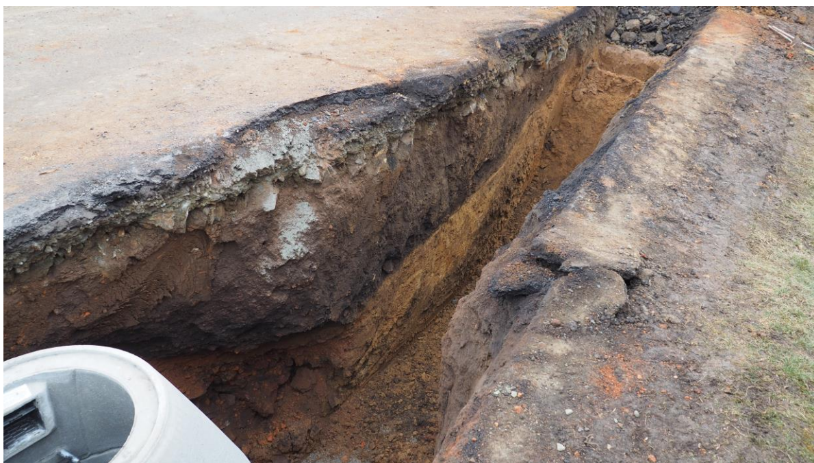
Obr. 11. Hradec u Stoda, III. etapa stavby kanalizace. Západní okraj příkopu (objekt 61) v jižní stěně výkopu, od SV.
