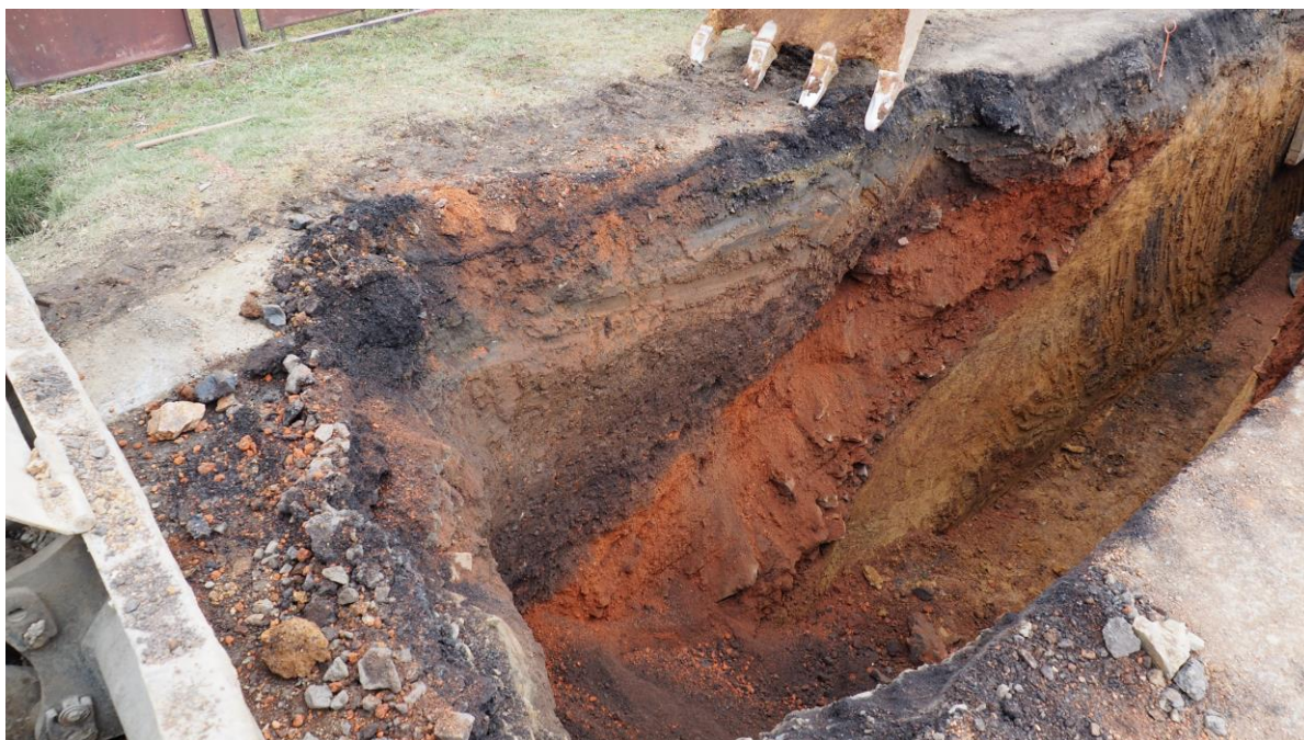
Obr. 10. Hradec u Stoda, III. etapa stavby kanalizace. Východní (vnitřní) okraj příkopu (objekt 61) starší fáze opevnění v severní stěně výkopu, od JZ.
