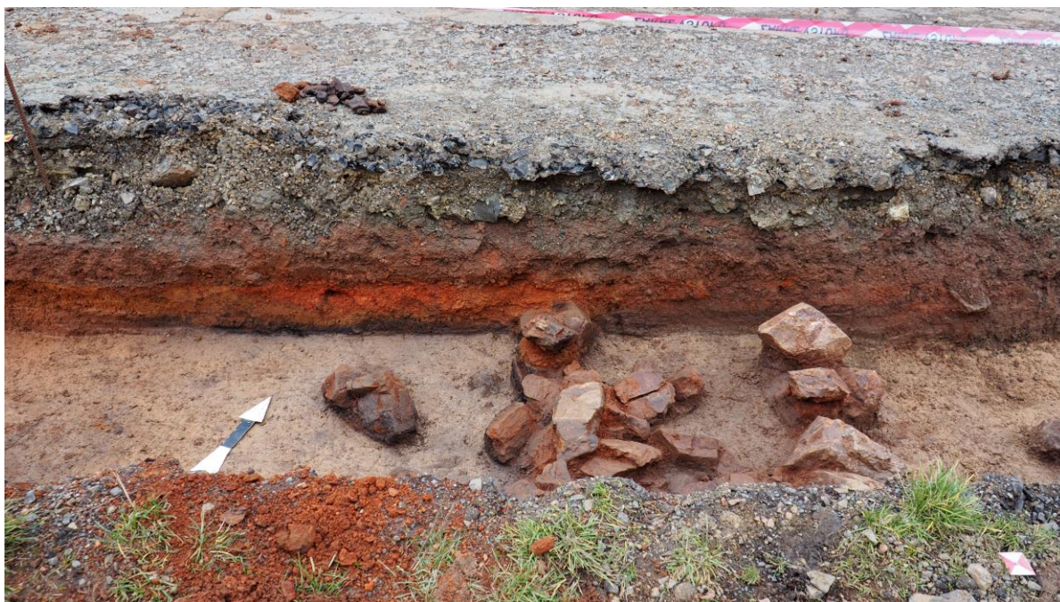
Obr. 3. Hradec u Stoda, III. etapa stavby kanalizace. Základ hradby (objekt 4) s vypreparovanou zadní kamennou plentou hradby s červenou vrstvou v severní stěně výkopu, od JJV.
