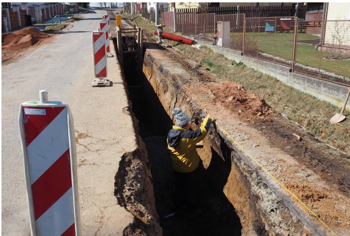
Obr. 12. Hradec u Stoda, III. etapa stavby kanalizace. Úsek výkopu v ulici na Lisov s objekty 55-57 v severní stěně, od V.
