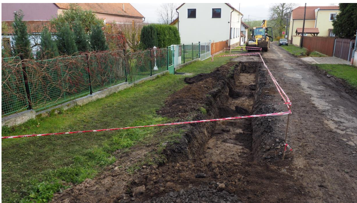
Obr. 8. Hradec u Stoda, III. etapa stavby kanalizace. Skrytý pás sondy v ulici jižně od křižovatky na předhradí, pohled od S.
