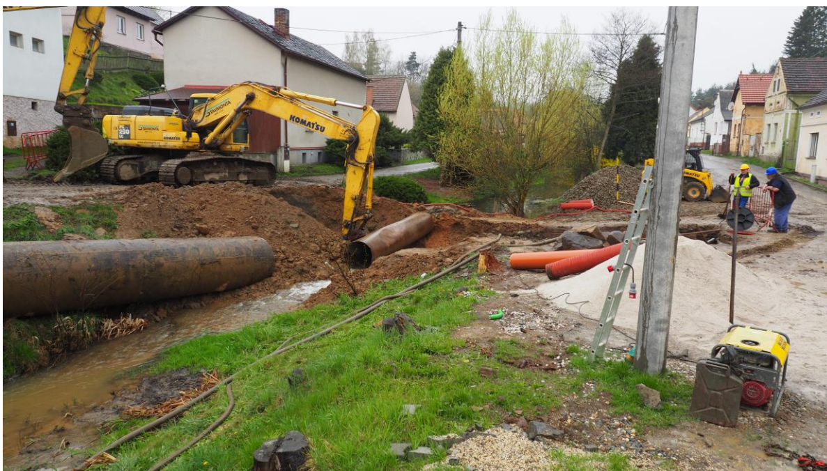
Obr. 17. Hradec u Stoda, III. etapa stavby kanalizace. Výkop kanalizace pod Touškovským potokem, od J.
