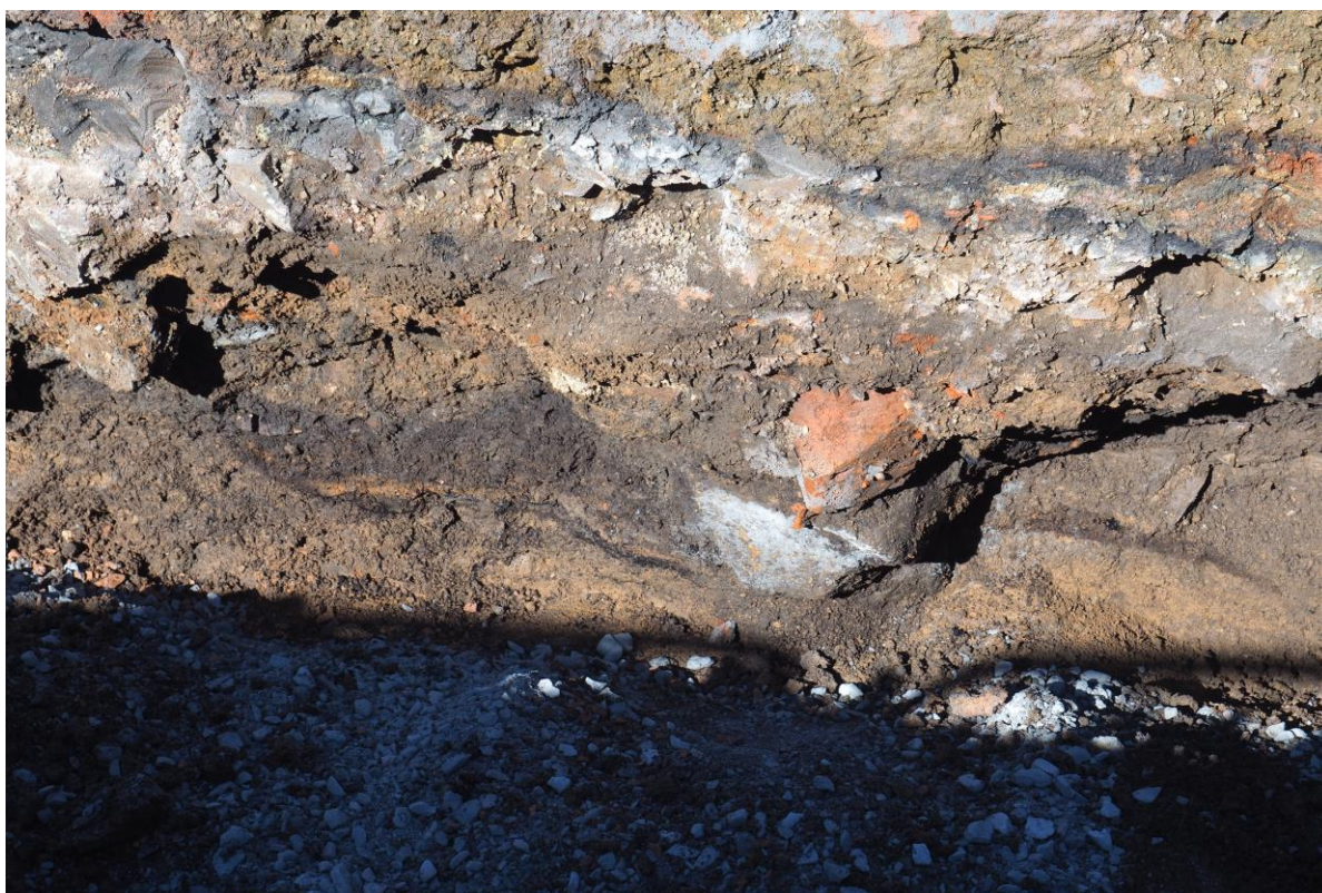
Obr. 13. Hradec u Stoda, III. etapa stavby kanalizace. Objekt 59 ve výkopu pod akropolí u Touškovského potoka v severní stěně výkopu, západní část, od J.
