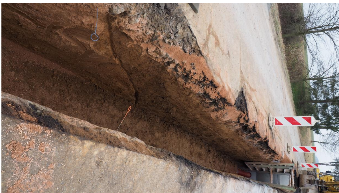
Obr. 14. Hradec u Stoda, III. etapa stavby kanalizace. Vnější příkop mladší fáze opevnění (objekt 62) v severní stěně výkopu, od JZ.
