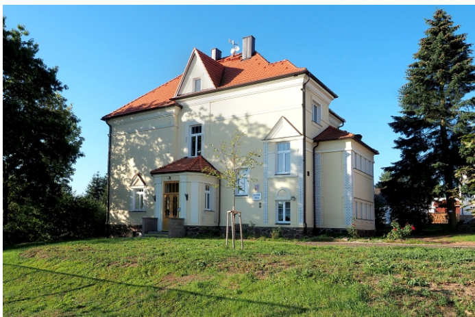
Pohled na budovu základní školy
