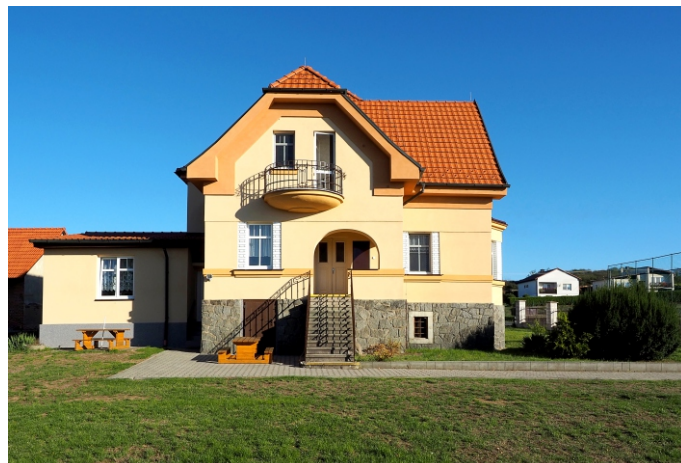
Pohled na budovu mateřské školy
